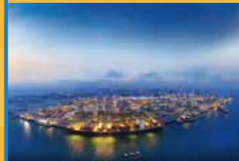
福州港江阴港区6、7号泊位20万吨级扩能工程项目核准及节能审查评审通过
